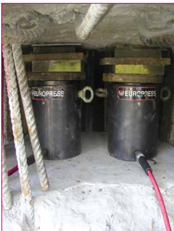
Realizzazione del "Second Bridge over the Panama Canal – Republic of Panama" per cui EUROPRESS ha fornito i componenti oleodinamici che sostengono i segmenti per la realizzazione dell'impalcato del ponte. (Panama, Luglio 2003)
